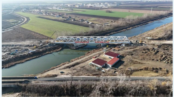
▲81标段钢桁架桥俯视图
