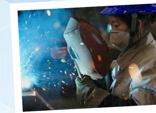
李云飞正在焊接钢构件 - 徐腾 中建钢构(华中)
