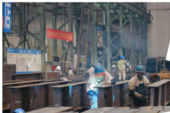
车间制造 - 徐腾 中建钢构(华中)
