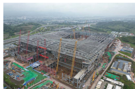
2023年，重庆科学会堂项目钢结构主体封顶
