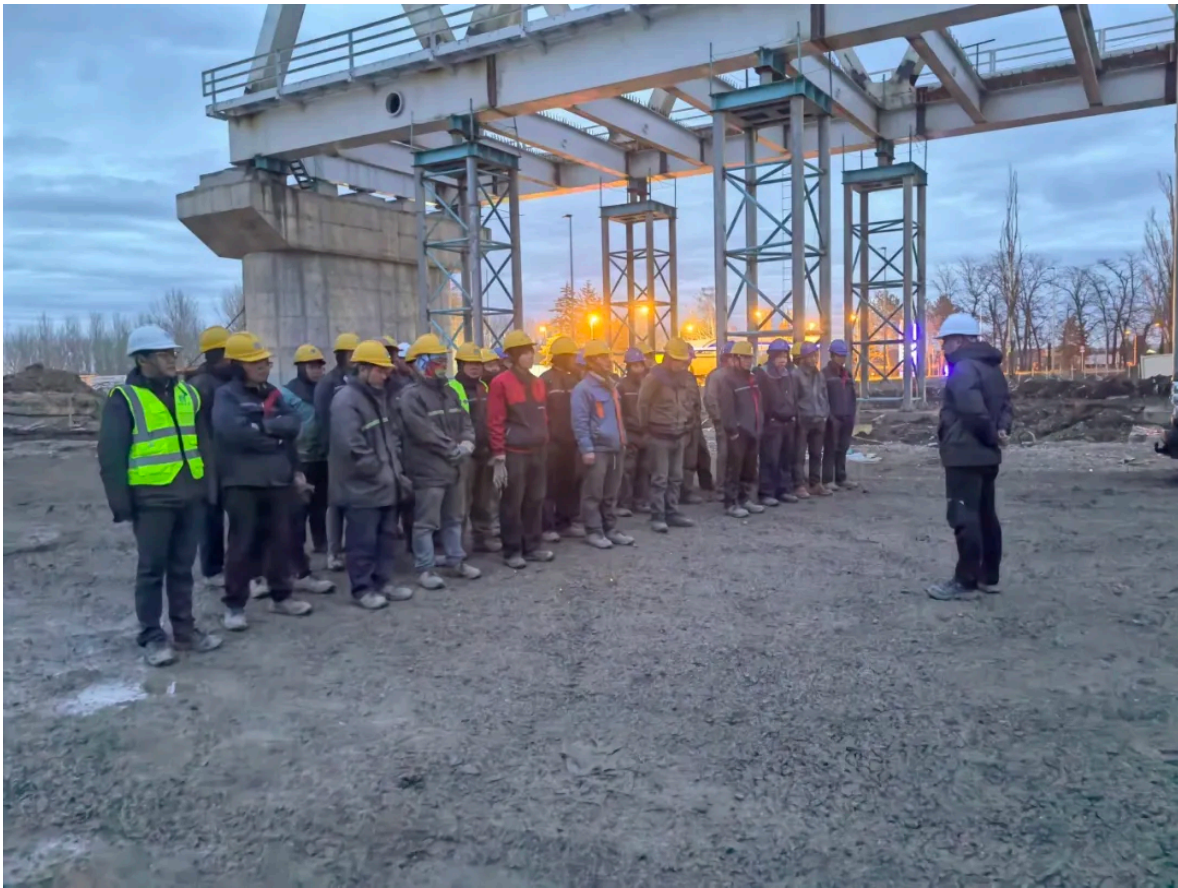
马春雨在塞尔维亚匈塞铁路钢桁架桥项目给工人开晨会
