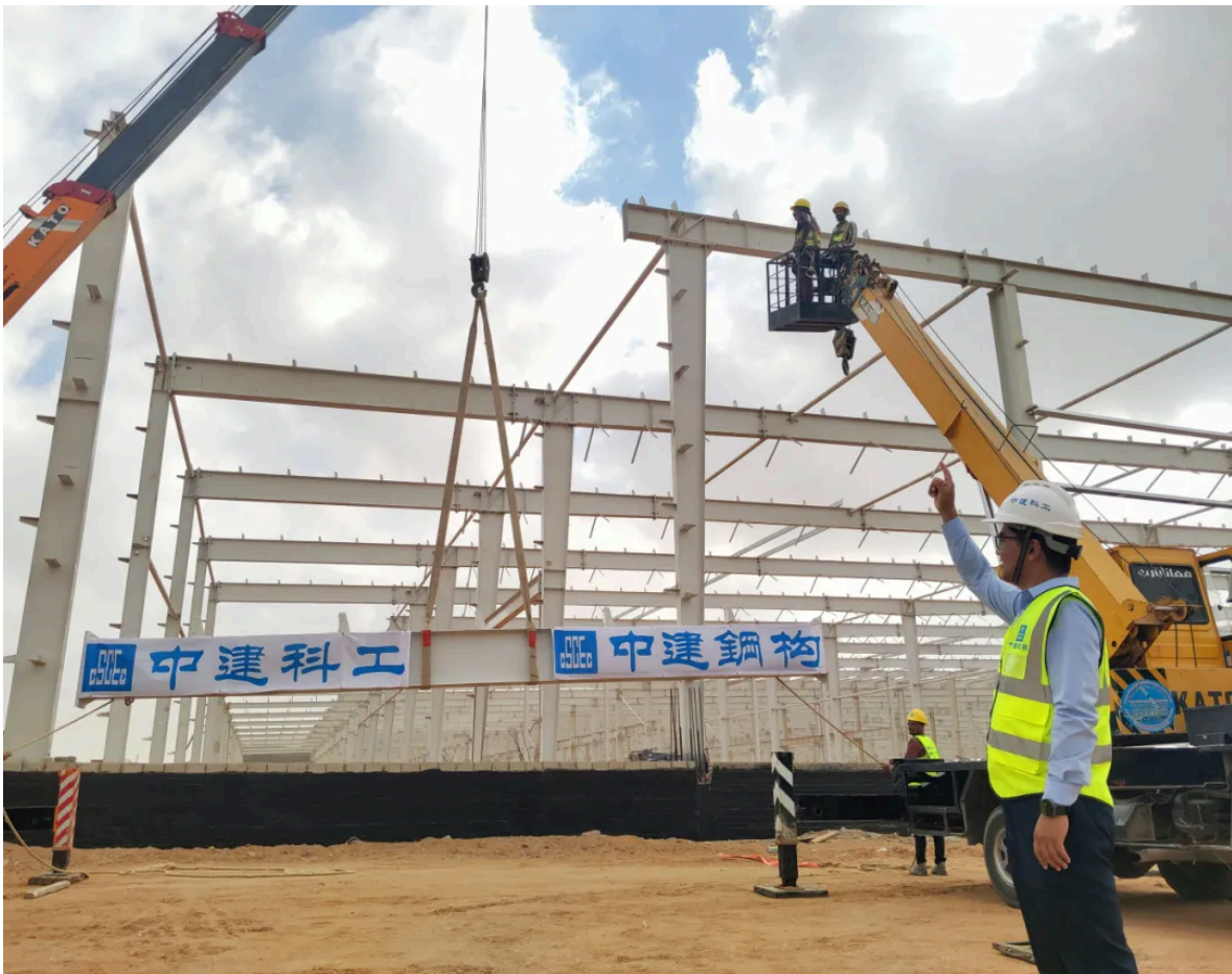
钢结构封顶，最后一根构件起吊
