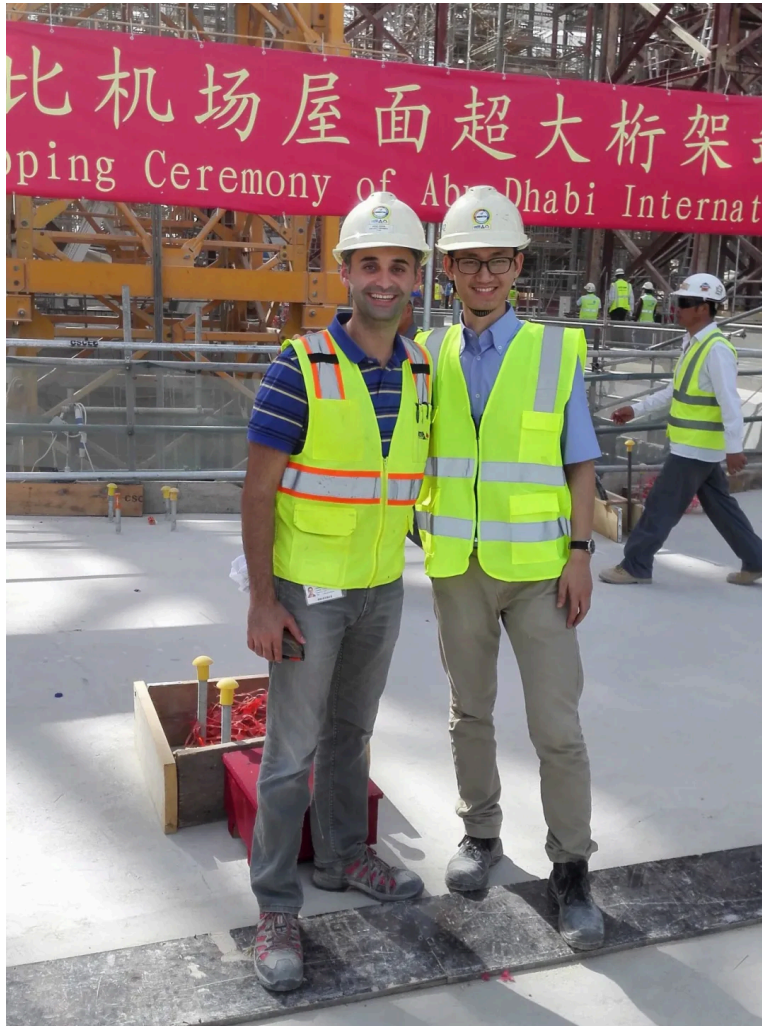
机场屋面超大桁架卸载后的合影留念（右为刘路）
