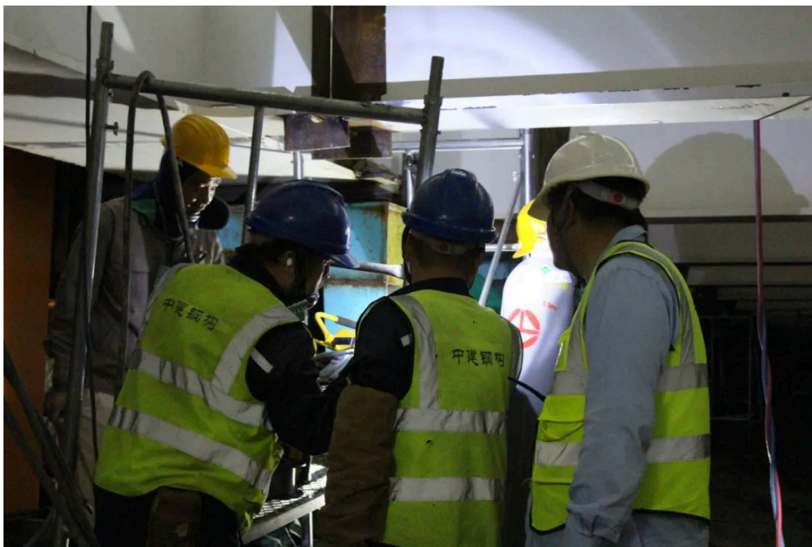
马春雨在KM81桥段顶推时期上夜班（右一）
