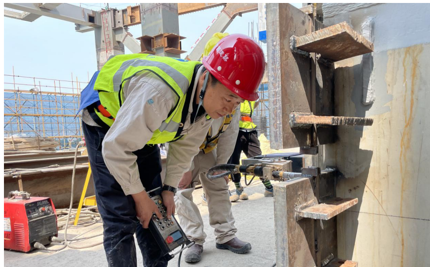
白新涛在项目现场调试焊接参数。
