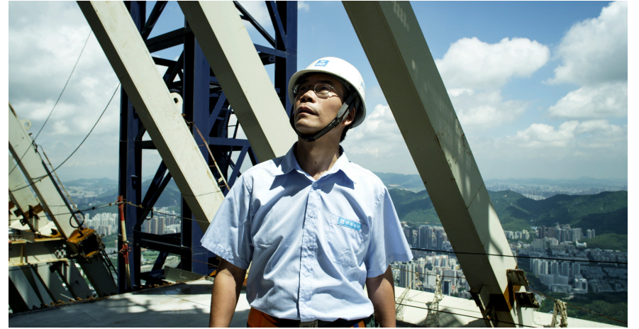
陆建新在深圳平安金融中心项目施工现场检查工作。
