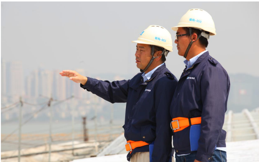
胡从柱（左）与徒弟在港珠澳大桥旅检大楼项目现场交流。
