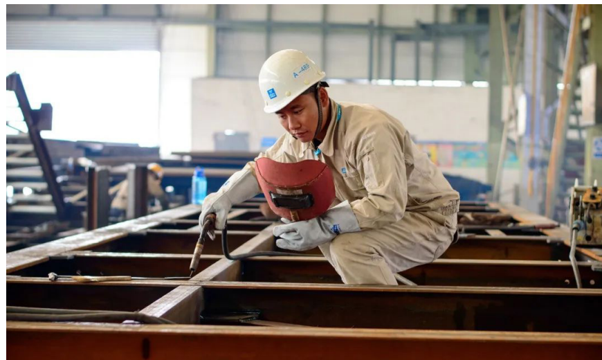
邱明辉在进行焊接作业。
