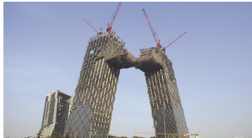
建设中的央视新台址项目。
