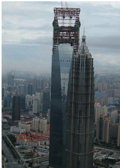
上海环球金融中心（施工中）。
